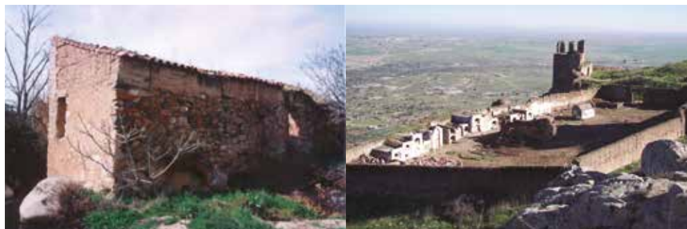
Molino de Los Caños y otra panorámica del cementerio del castillo antes de la restauración de su muro
