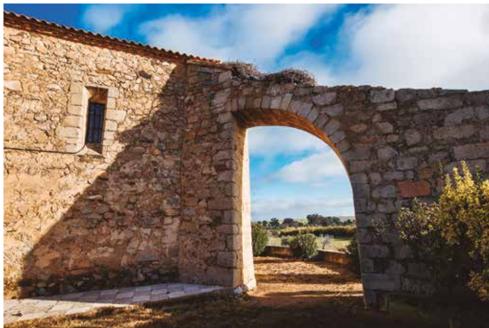
Arbotante de refuerzo
