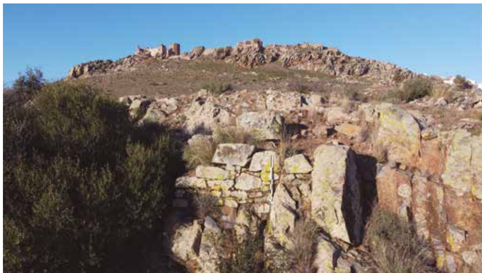
Base de una de las torres defensivas del Cerro de la Horca
